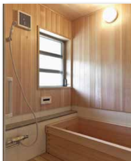
図5 ヒノキ材の浴室・浴槽
