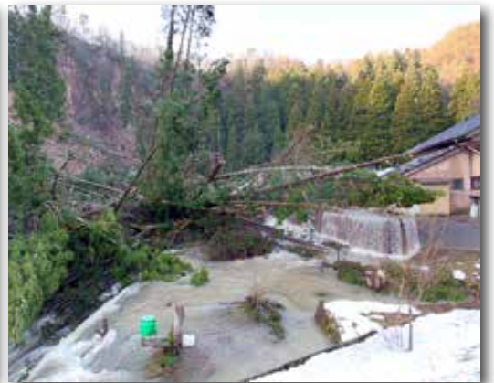
地滑りで河川の流が止まり水が住宅に流れ込む様子。
